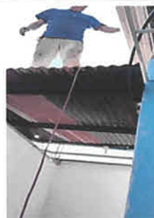
Foto 4: Retiro y colocación de lámina.
