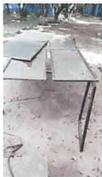
Foto 1: Fabricación de puerta
