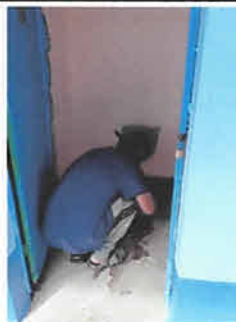
Foto 6: Inodoros en mal estado.
