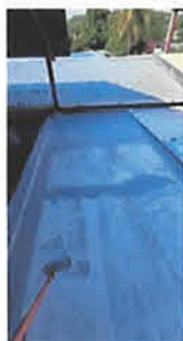
Foto1: Impermeabilización de techo de Dirección..
