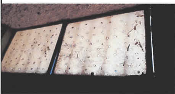
Foto 5: Desinstalación de ventana
