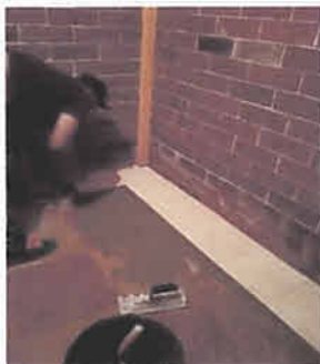
Foto 5: Instalación de piso
