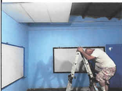
Foto 3: Instalación de cielo falso.
