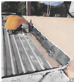
Foto 3: Reparación de Techo de bodega para alimentos en mal estado.
